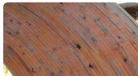
Scheurtjes door delaminatie © SGI
