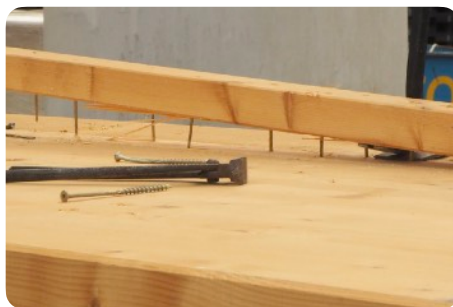
Verwijderen van metalen onderdelen
