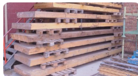
Opslag van gerecupereerde balken van GGH
