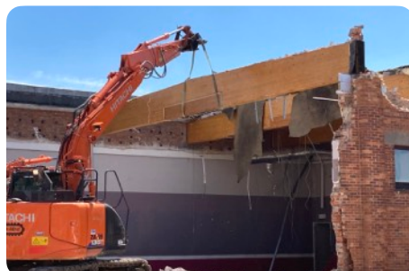
Demontage van balken van GGH
