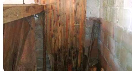
Aantasting door langdurige blootstelling aan vocht © SGI
