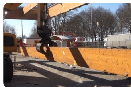
Demontage van balken van GGH
