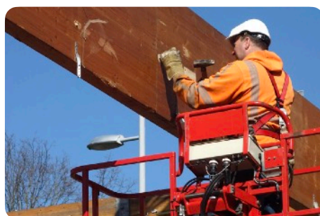
Vorbereiding voor demontage
