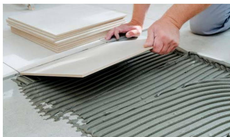
Tegellijm verdeeld door Lijmkam
