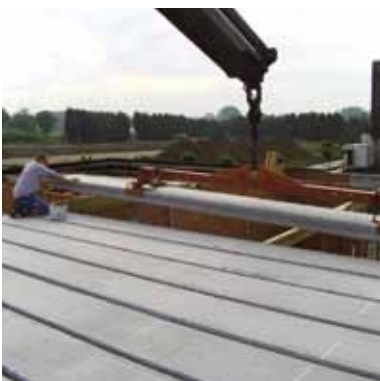
plaatsing door kraanwagen
