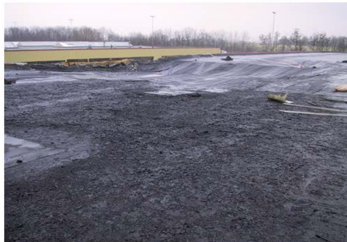
Scheiding tussen bitumineuze afdichting en Resitrix
