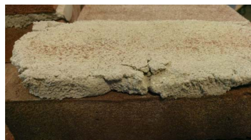
Bezweken mortel bij UNI 12 spouwanker
