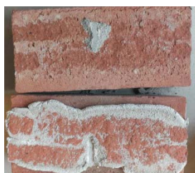
Figuur 140: Hechtoppervlak van proefstukken met ‘Gebrek 3’ van het UNI-Lijm spouwanker.
