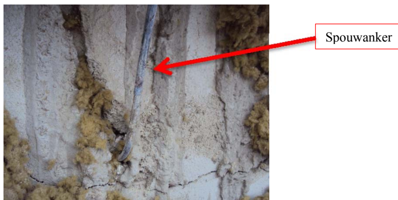
Figuur 114: Omgebogen spouwanker na inmetelen in het binnenblad.
