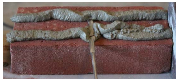
Figuur 49: Ingelegde lijmspouwanker in de lijm mortel.
