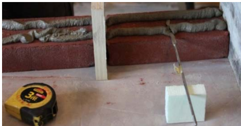
Figuur 137: Aanbrengen lijmmortel op stenen,
