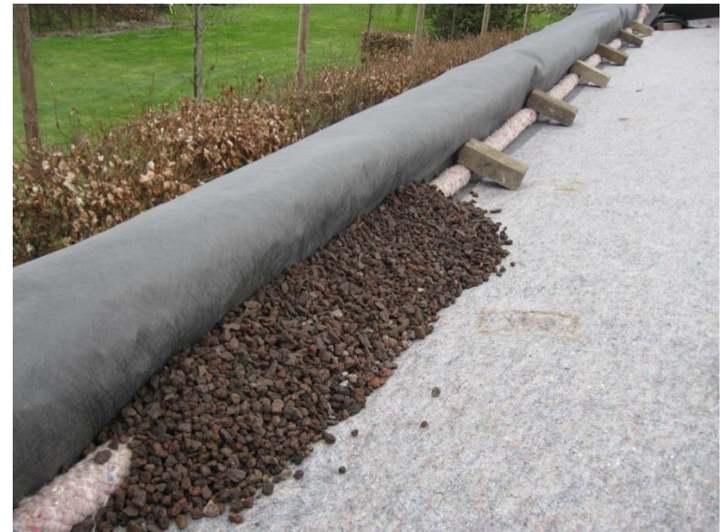
Drainage bedekken met lava en filtervlies
