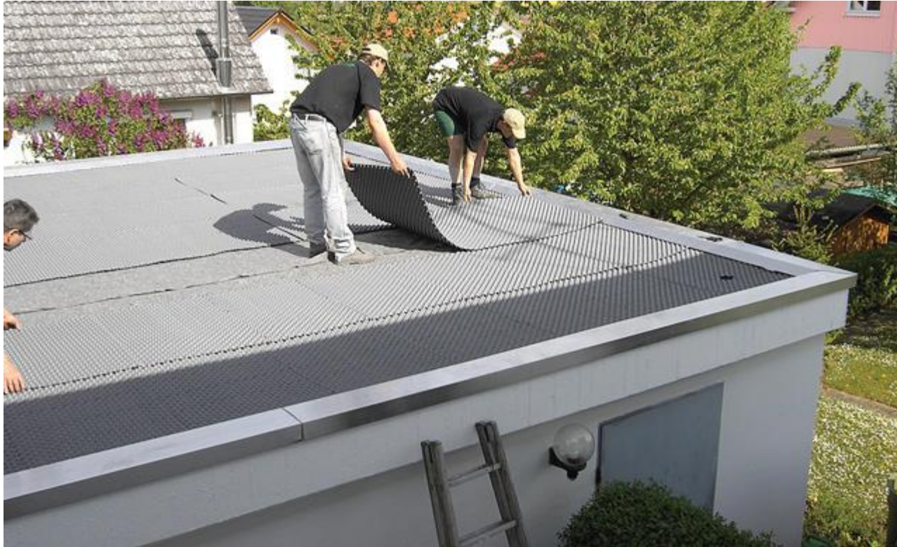
Drainageplaten leggen (overlappen en afvoer uitsnijden)
