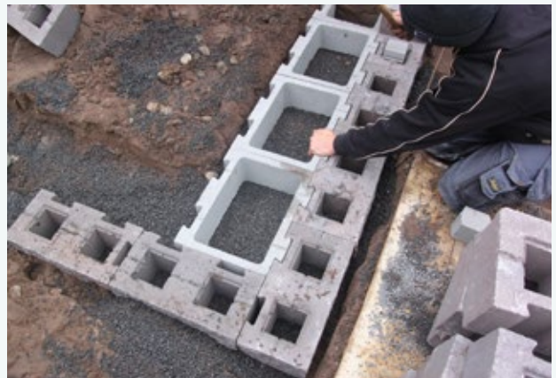
Plaatsen counterblok achter G-blok.
