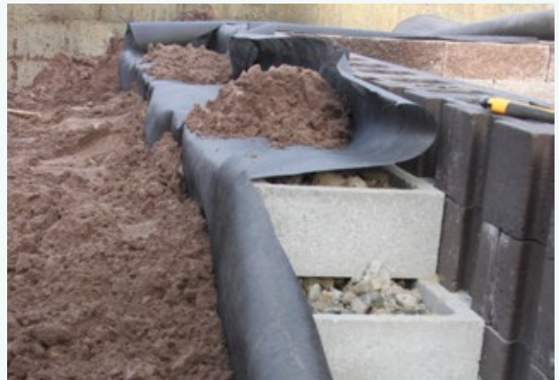
Aanbrengen worteldoek op bovenste counterblokken.
