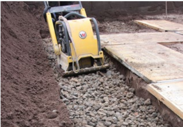
Aanvullen met gerecycleerd beton 10/40 tot 20/40 en afrillen.
