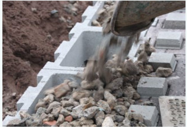
Vullen counterblok met gerecycleerd beton 10/40 zonder zandaandeel.
