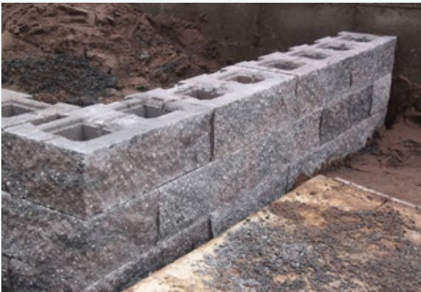
Plaatsen van volgende lagen G-blokken en counterblokken.
